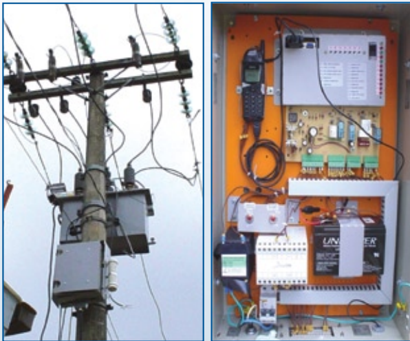
Figura 3: Religador de energia utilizando celular TDMA
