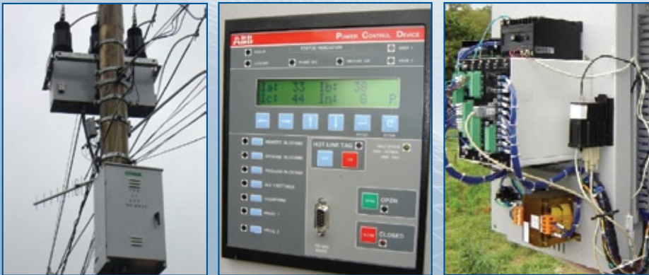
Figura 5: Religador de Energia utilizando modem GPRS
